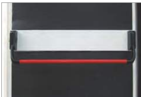
▲ Maniglione anti-panico interno montato su porta laterale
