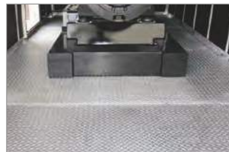
▲ Pavimentazione interna in lamiera zincata mandorlata
